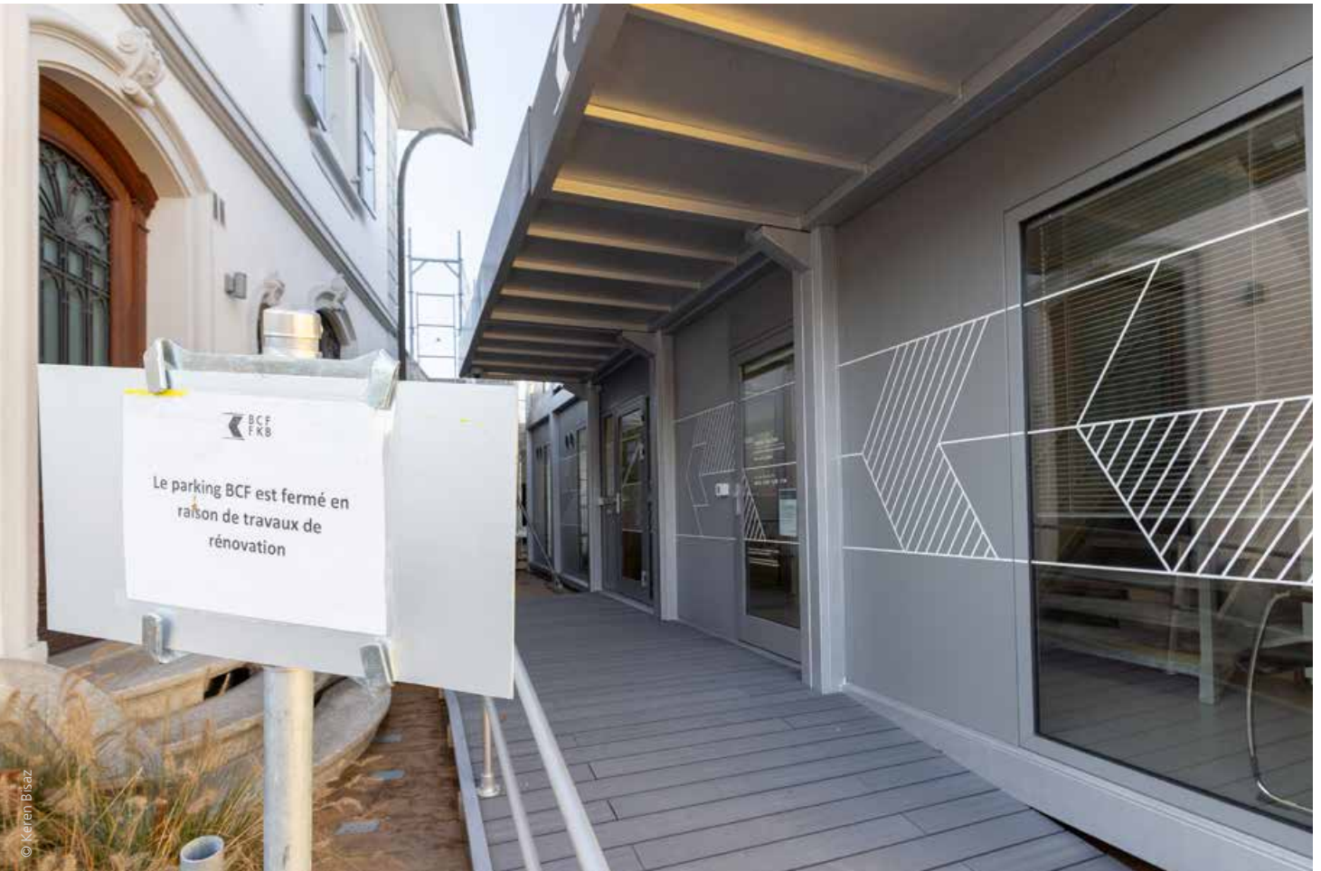
Renovierung der Niederlassung Estavayer-le-Lac
