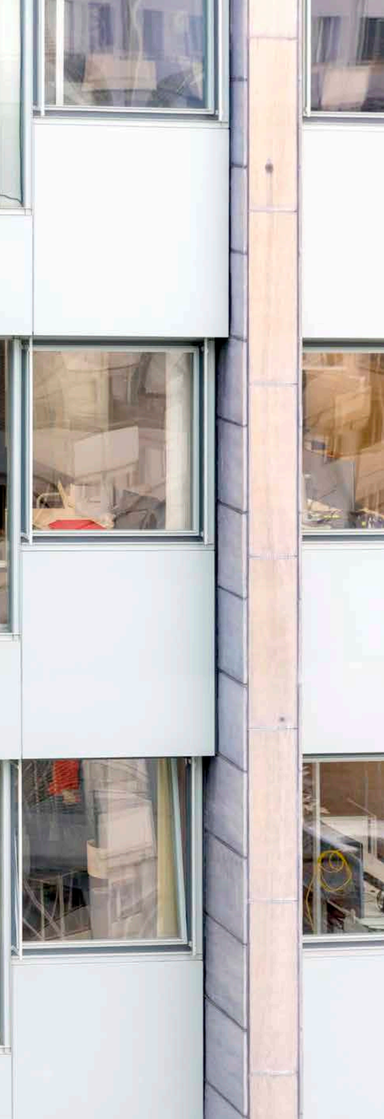
Neugestaltete Büros in der 4. und 5. Etage des Sitzes in Freiburg
