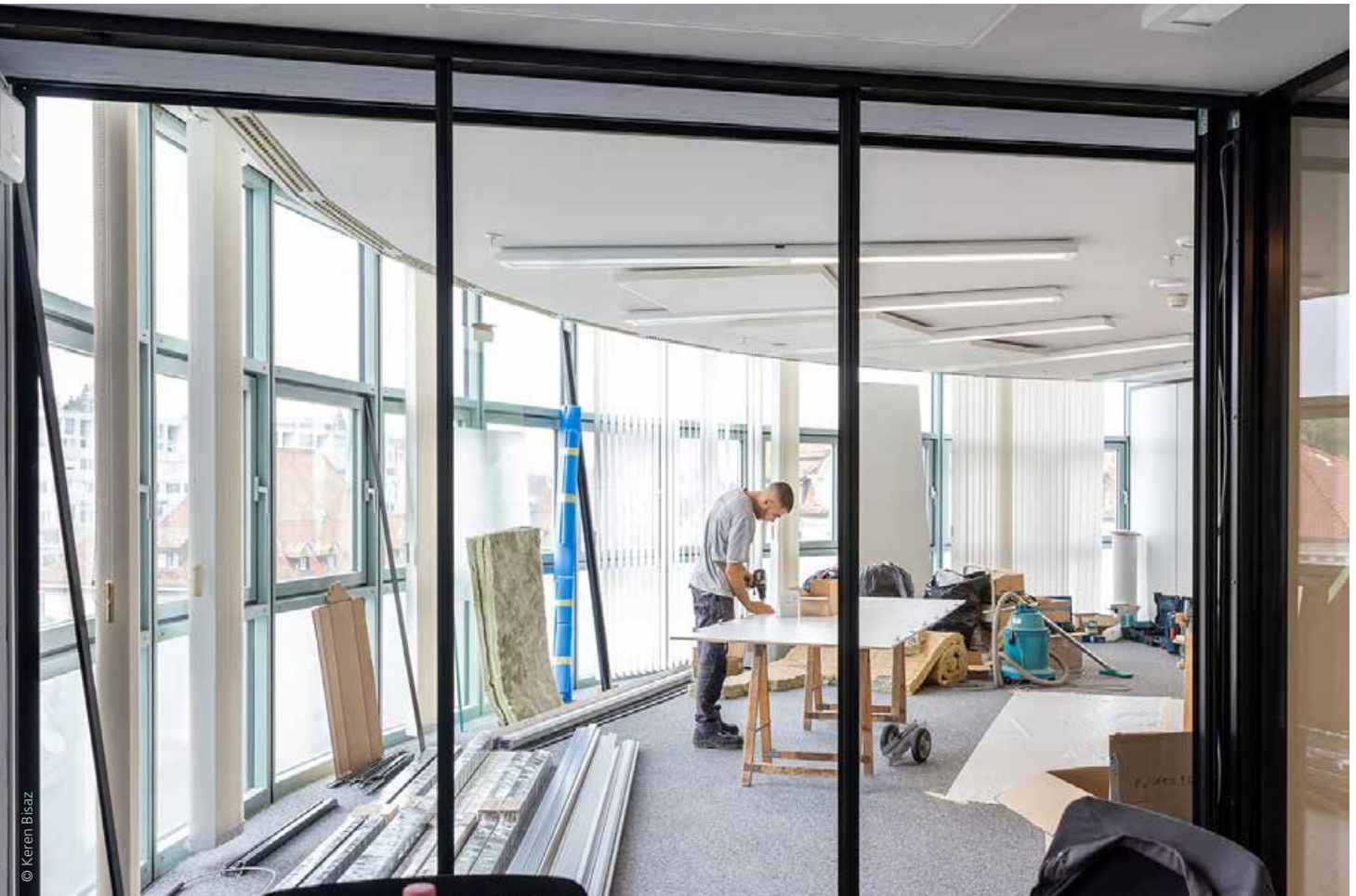
Neugestaltung der Büros der Generaldirektion am Hauptsitz
